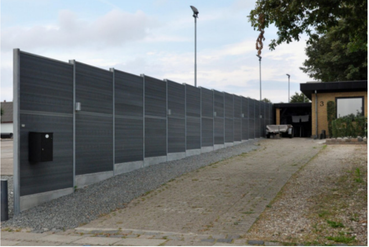
ŞEKİL 2.12. Thisted, Danimarka'da Cam Elyafından Üretilmiş Gürültü Bariyeri
