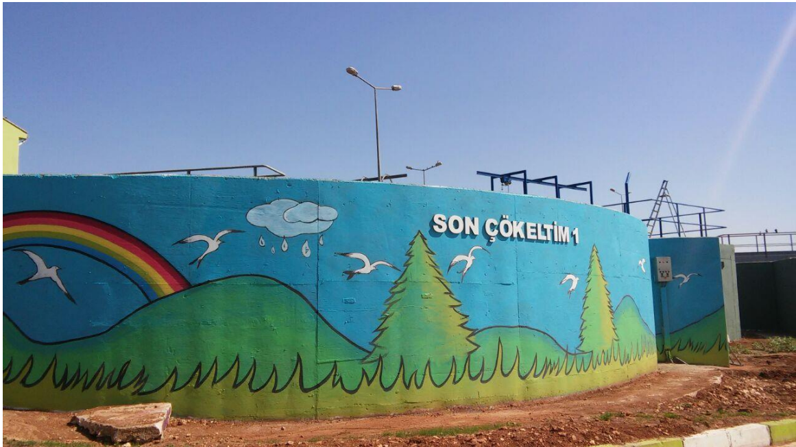
Şekil 3.2 SUOSB Atıksu Arıtma Tesisine Ait Bir Fotoğraf (SUOSB, 2022)
