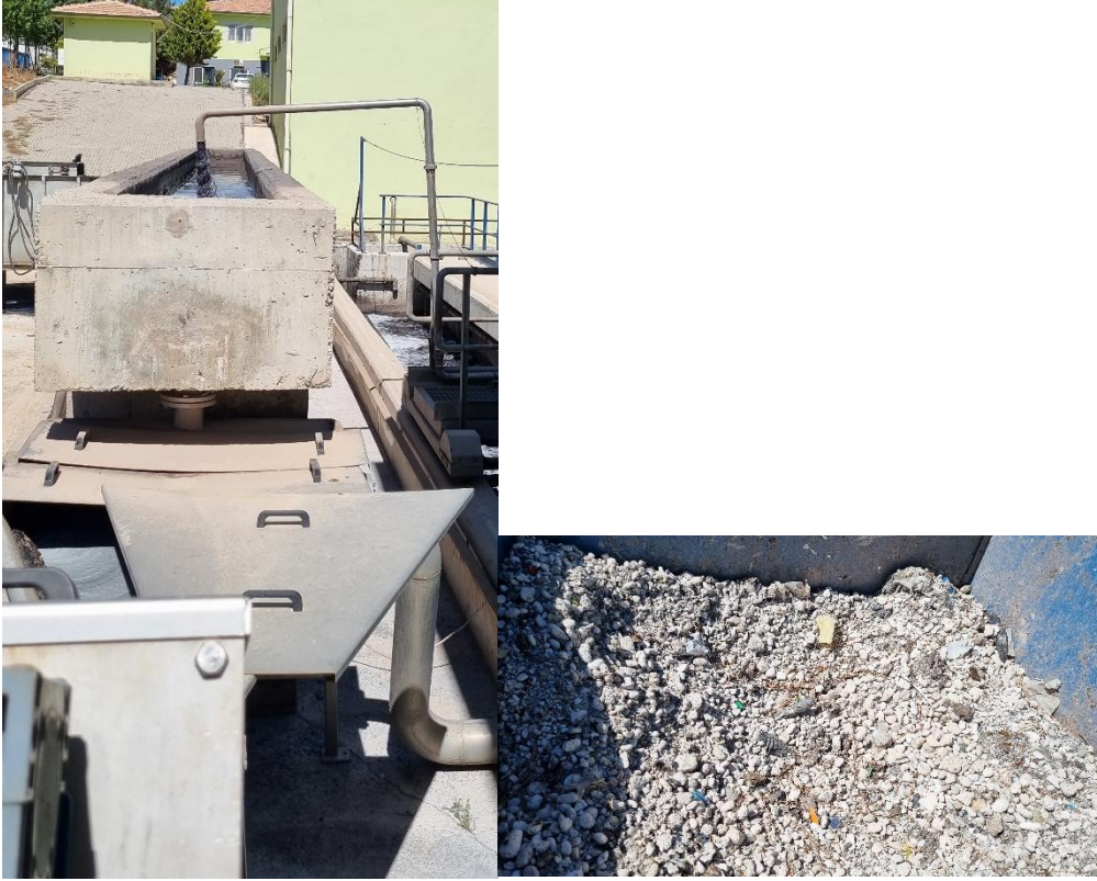
Şekil 3. Şanlıurfa OSB AAT kum tutucu ve toplanan atık
