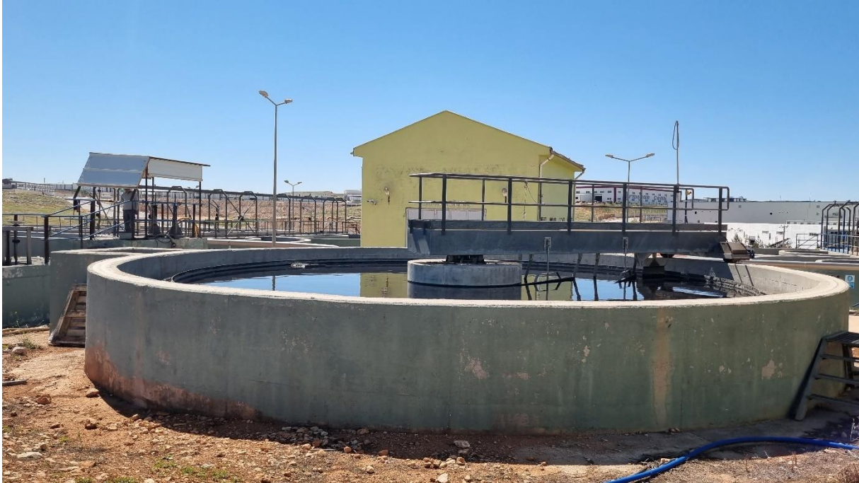
Şekil 4. Şanlıurfa OSB AAT ön çöktürme tankı
