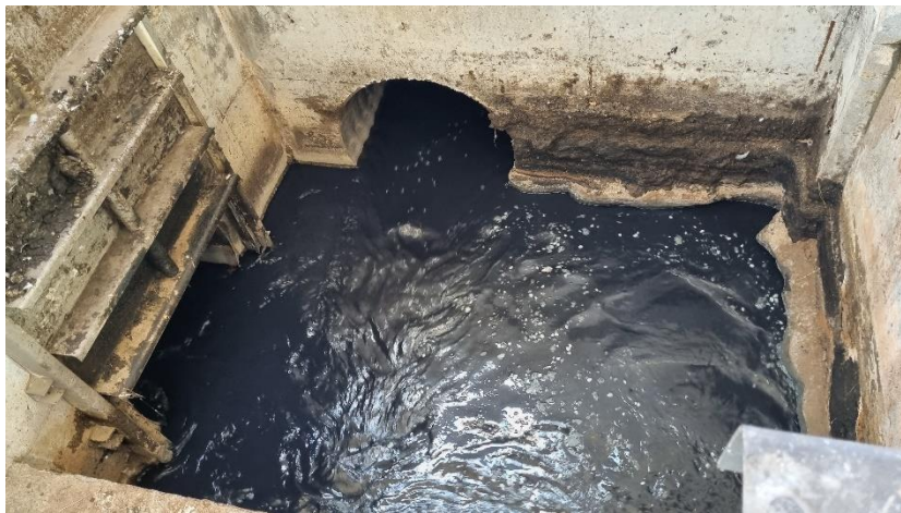
Şekil 2. Şanlıurfa OSB AAT giriş suyu
